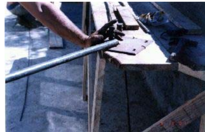
Dobramento manual com chave e chapa metálica
